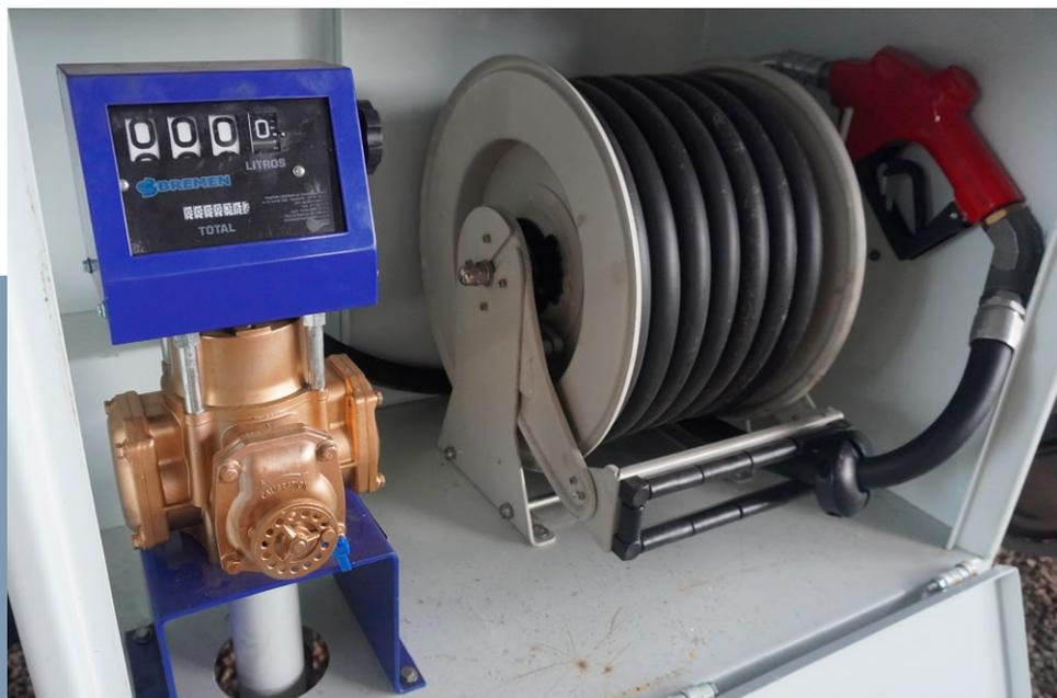
Bomba de distribuição, medidor volumétrico e carretel auto retrátil com mangueira e bico para abastecimento conforme a necessidade do cliente.
